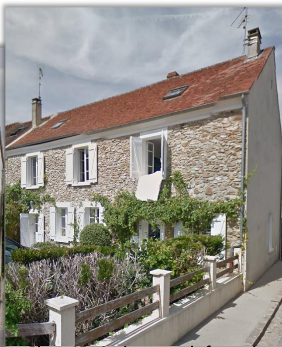
Photo 15 : Ancien corps de ferme du hameau de Rentilly
