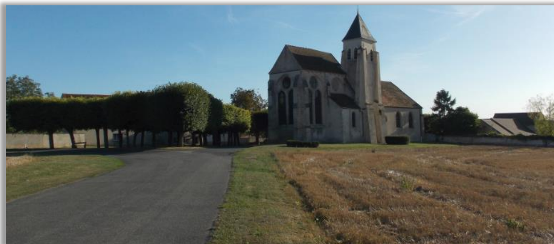
Photo 8 : Entrée du centre bourg par l'Est de la commune depuis la D 217E
